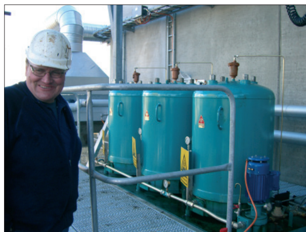
Hr. Steen Christensen, Driftsmester, Koppers A/S ved CJC™ Finfilter HDU HP 3x427/81 MZ
