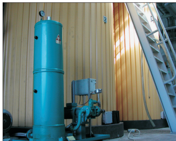
Til dybdefiltrering af varmetransmissionsolie-anlæg er udviklet en ny type CJC™ Finfilter, der kan modstå det høje tryk som findes i systemet. Modellen hedder HP 27/108 og er p.t. i funktion hos Daloon, hvor der filtreres på to store kedler, som hver især indeholder ca. 7.000 liter varmetransmissionsolie.
