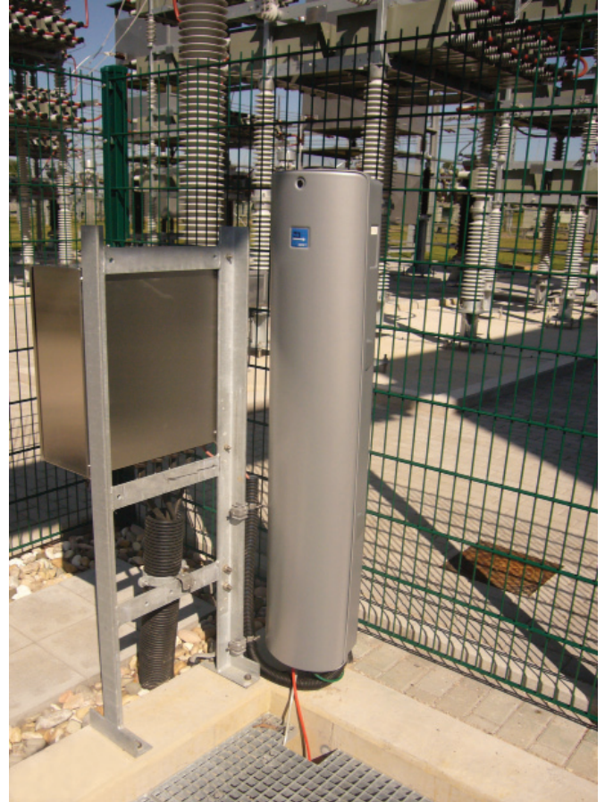
SIPP Node™ installato su una vasca di raccolta di una stazione trasformatori
