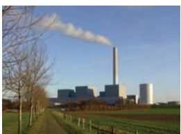
Elsam A/S, Studstrupværket, Denmark
